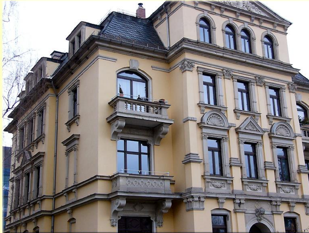
Wohnhaus Schubertstraße Komplettsanierung
