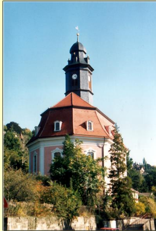
Loschwitzer Kirche Dacheindeckung
