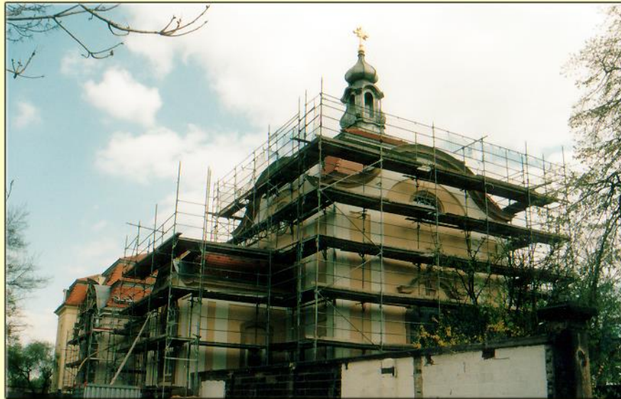
Matthäuskirche in Dresden Friedrichstadt Einrüstung
