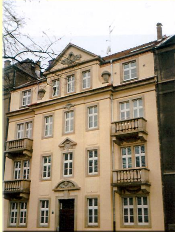
Wohnhaus Schlüterstraße 1 Komplettsanierung
