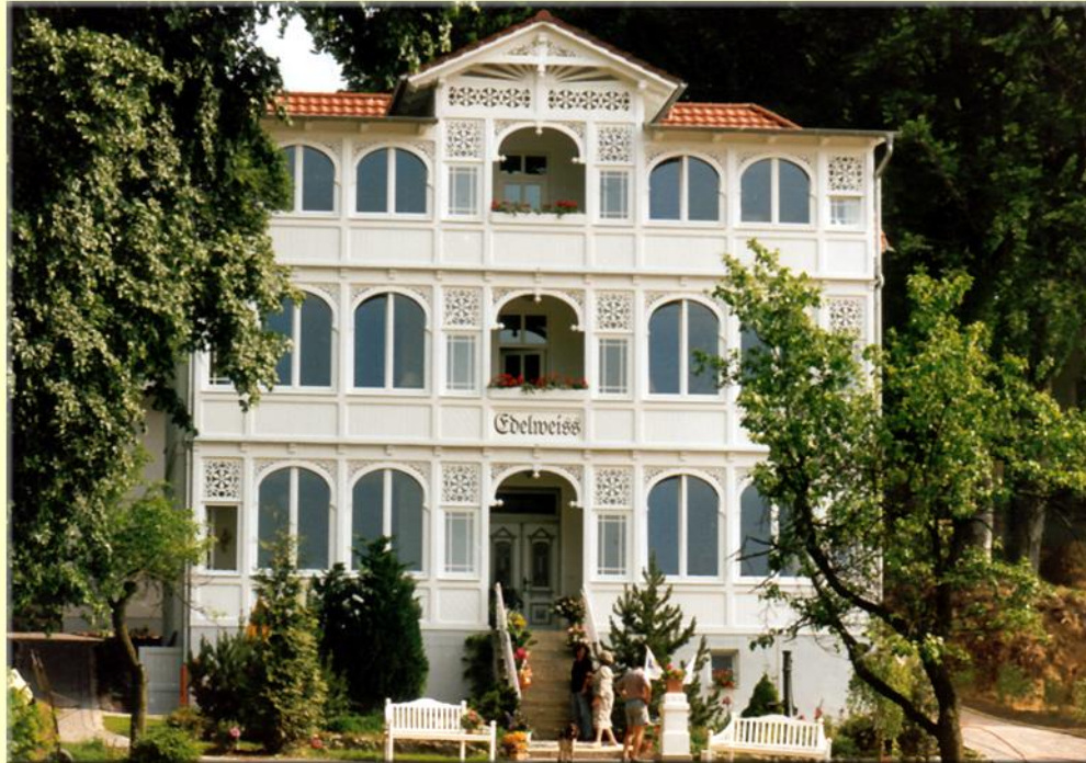
Denkmalgeschütztes Gebäude mit Porta - Fenstern
