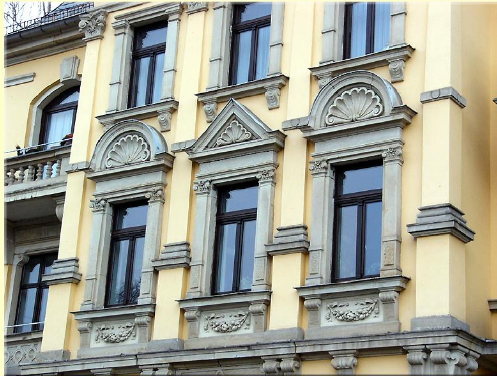
Wohnhaus Schubertstraße Komplettsanierung
